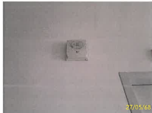
อุปกรณ์ส่งเสียงสัญญาณแบบกระดิ่ง ระบบตรวจสอบและแจ้งเหตุเพลิงไหม้
