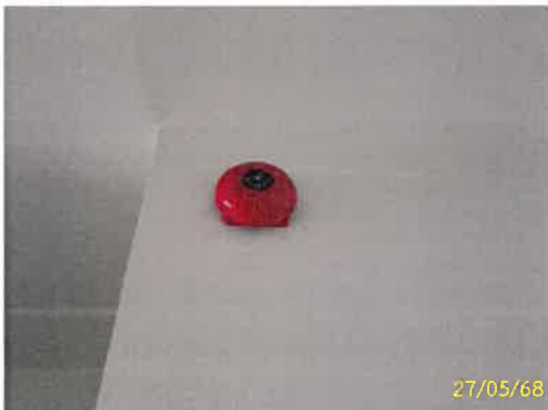
อุปกรณ์ส่งเสียงสัญญาณแบบกระดิ่ง ระบบตรวจสอบและแจ้งเหตุเพลิงไหม้
