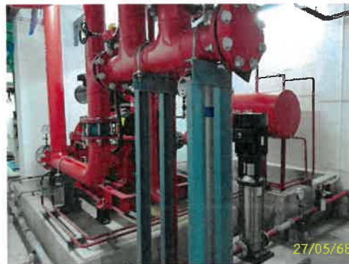
ปั๊ม เก็บน้ำสำรองเพื่อการดับเพลิง ภาพที่ 2.2-11 (ต่อ) ระบบน้ำใช้
