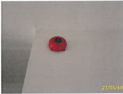
อุปกรณ์ส่งเสียงสัญญาณแบบกระดิ่ง ระบบตรวจสอบและแจ้งเหตุเพลิงไหม้ (ต่อ)
